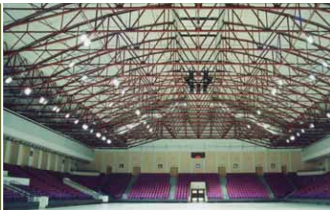
Hala Torwar – dzięki symulacjom komputerowym uzyskano kompromis między kosztami a komfortem akustycznym
