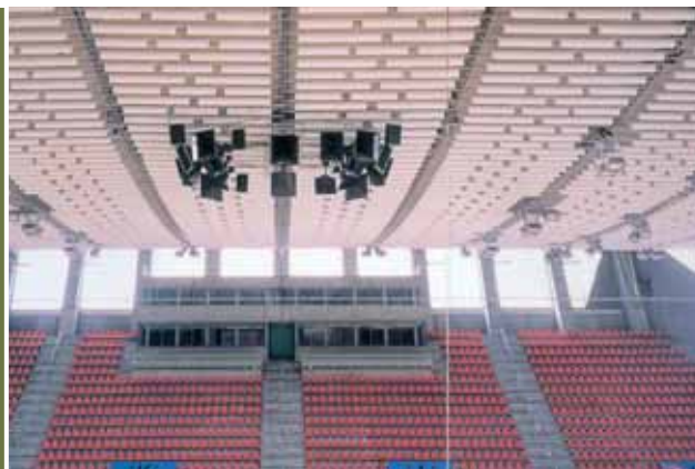
Wzór do naśladowania – wklęsły dach z elementami rozpraszająco-tłumiącymi
