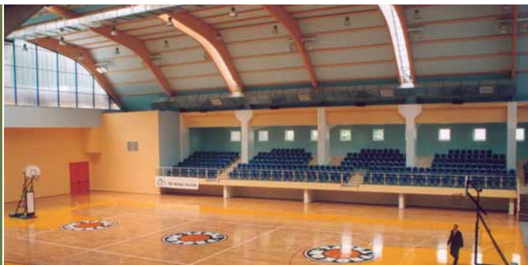
Ta piękna nowa hala wymaga adaptacji akustycznej
