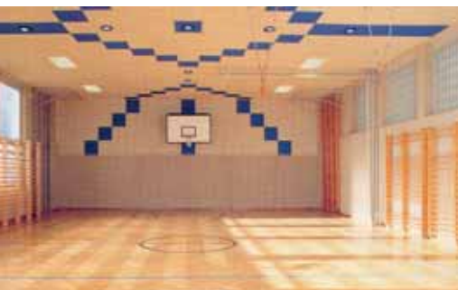
Sala sportowa z wytłumieniem w postaci płyt z wełny drewnianej
